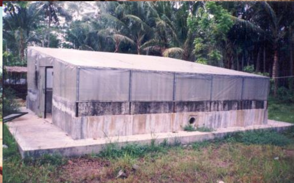
Pengeringan Dengan Efek Rumah Kaca ( Solar Dryer )
